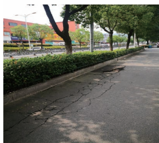
图4 路面病害事件整改前
