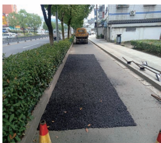
图5 路面病害事件整改后
