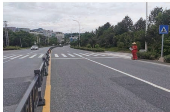
图 28 交叉口治理整改后
