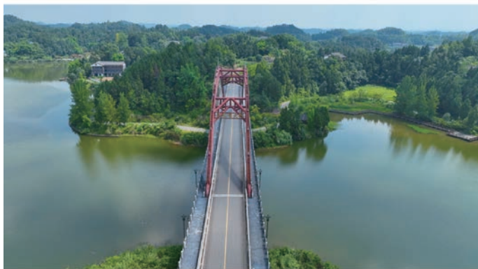
图5 新改建农村公路桥梁——青龙咀大桥图片
