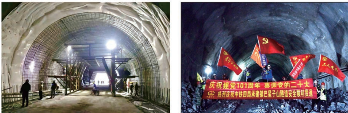
图8 镇巴县星子山隧道及引线工程
