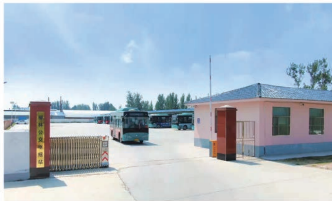
图 16 巨野县柳林镇公交枢纽站
