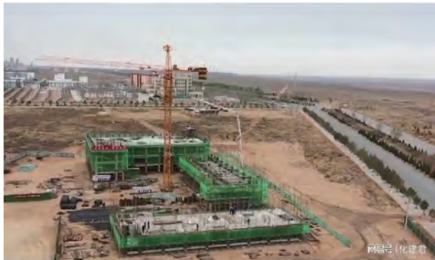
图 11 润阳悦达多晶硅项目施工现场
