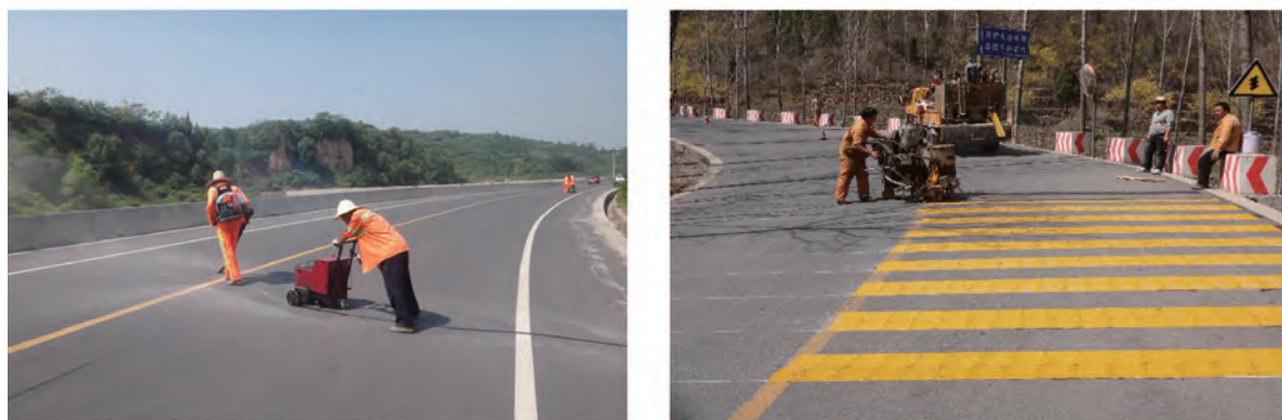
图5 县乡公路日常养护
