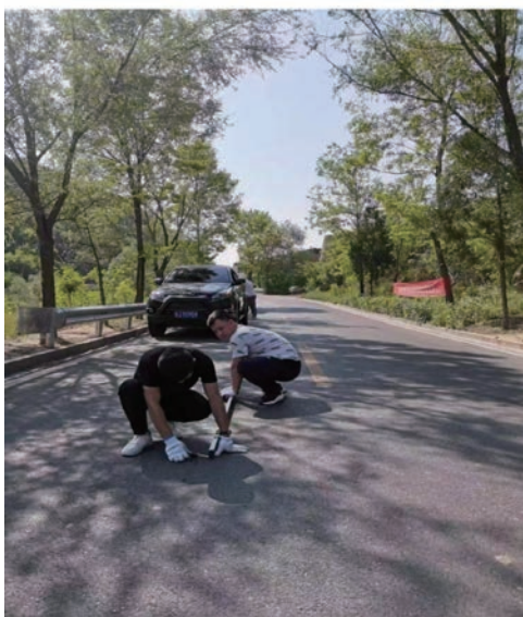
图 8 检测路面平整度
