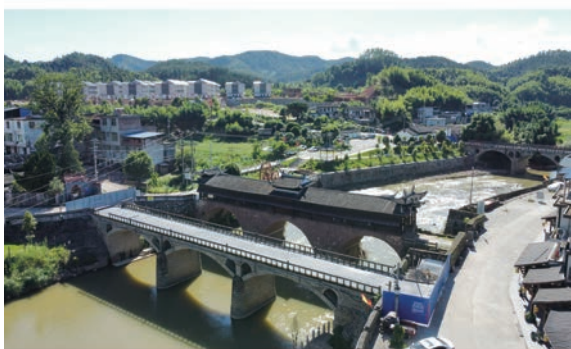
图4 贡川项目桥梁改造
