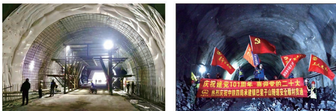
图8 镇巴县星子山隧道及引线工程
