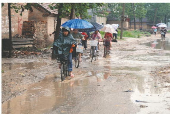
图9 曹县大集镇道路改造前
