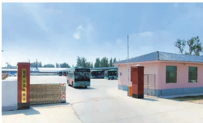
图 16 巨野县柳林镇公交枢纽站
