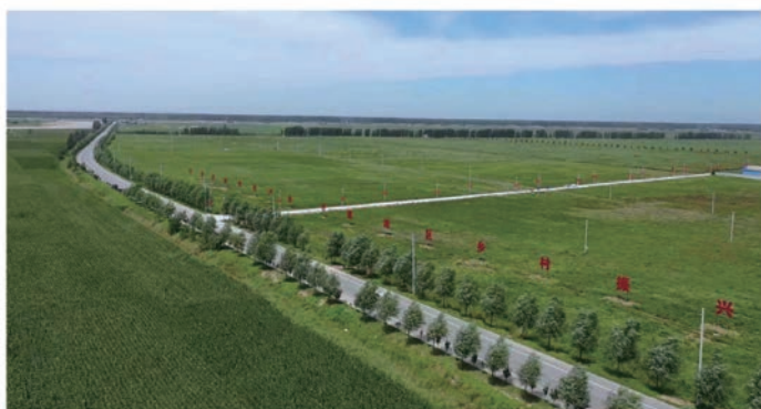
图 11 建成的黄河滩区居民迁建道路
