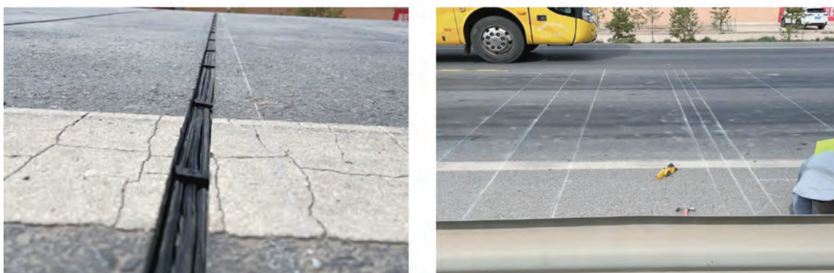
图 12 动态称重设备安装
