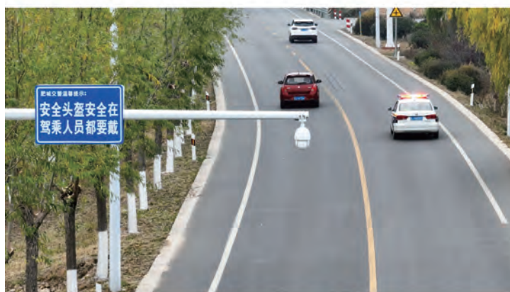
图 5 道路监控系统
