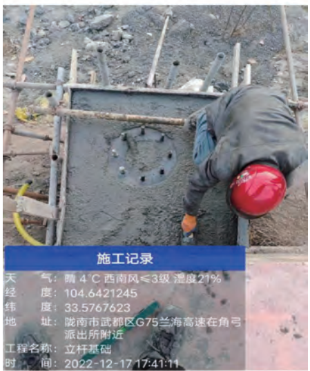
图4 工程施工记录
