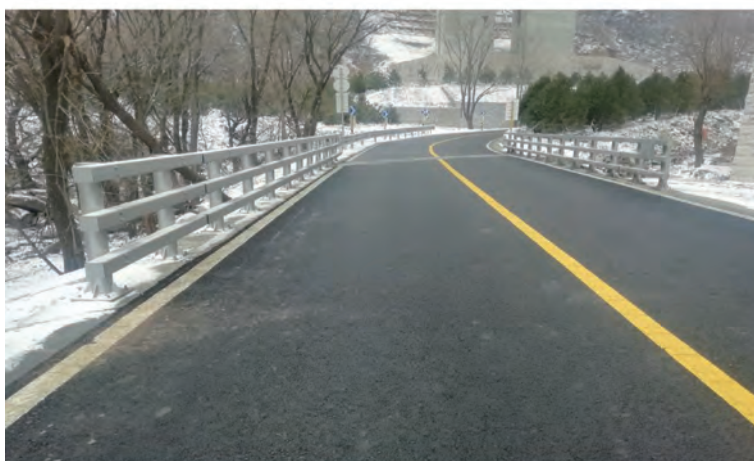
图 21 松闫路安防工程完工后
