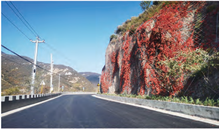
图 22 边坡防护工程中保护沿线乔灌木
