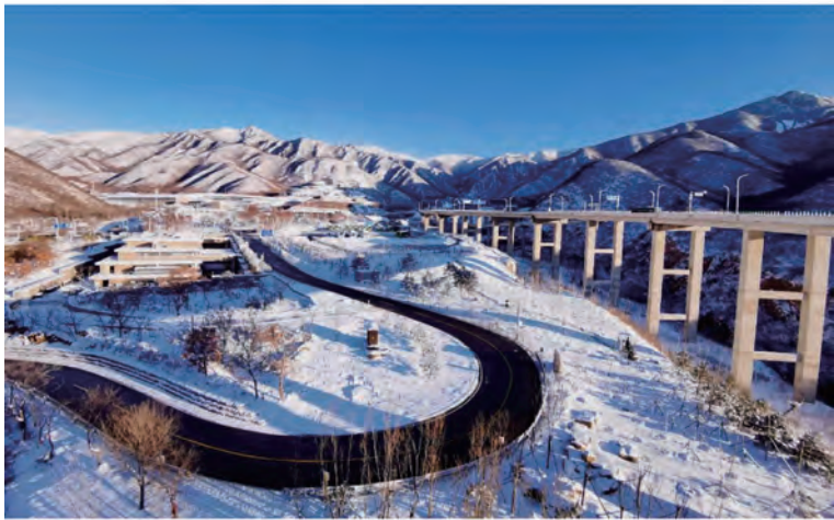
图 24 铲冰除雪作业后的路况
