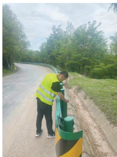
图9 安装智能传感设备
