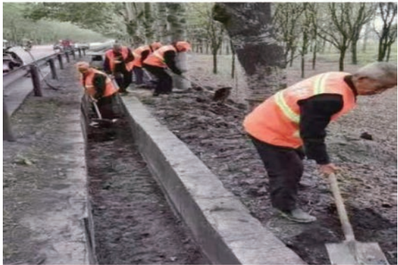
图 2 养护人员清除排水渠
