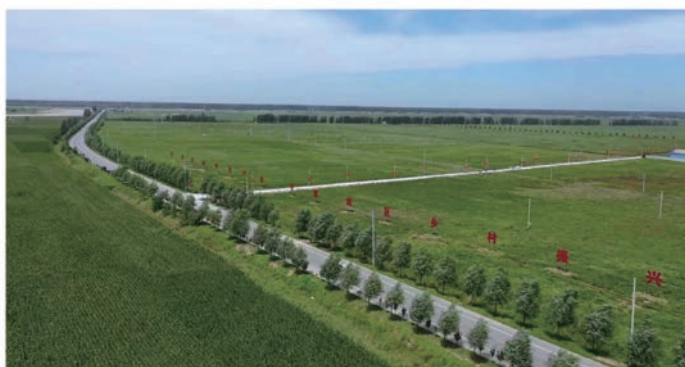
图 11 建成的黄河滩区居民迁建道路
