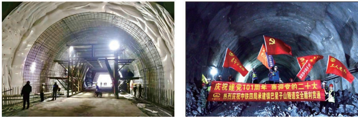
图8 镇巴县星子山隧道及引线工程
