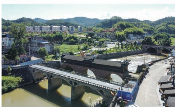
图4 贡川项目桥梁改造
