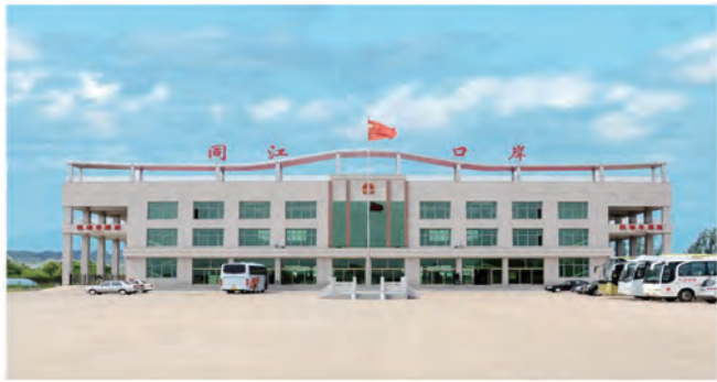
图6 同江口岸东港联检大楼
