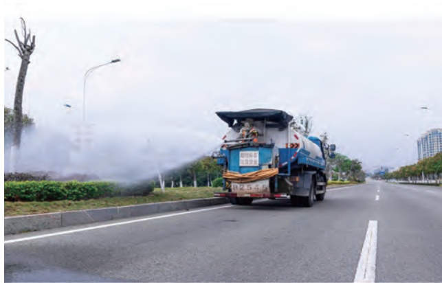
图 6 道路养护作业
