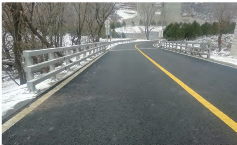
图 21 松闫路安防工程完工后
