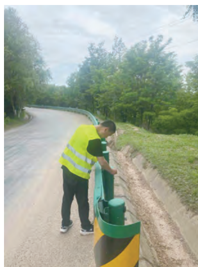
图9 安装智能传感设备
