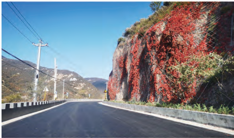
图 22 边坡防护工程中保护沿线乔灌木
