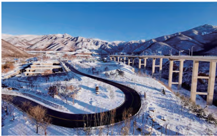
图 24 铲冰除雪作业后的路况
