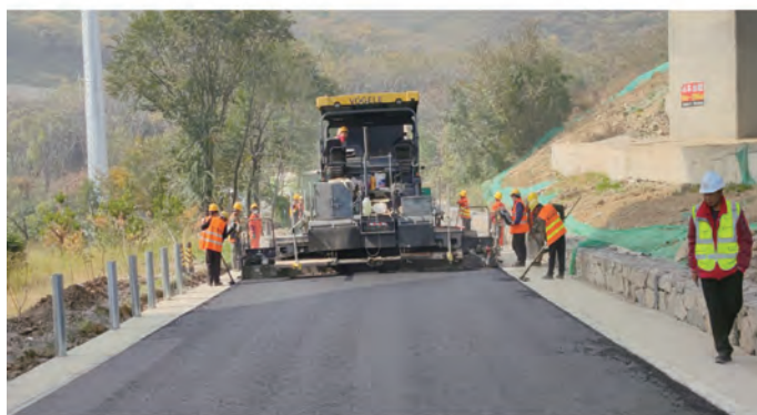
图 11 铺设 DTC 相变融冰雪材料
