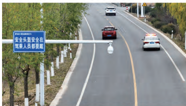
图 5 道路监控系统
