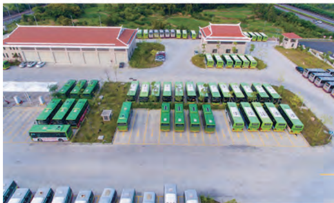
图 7 惠安综合交通枢纽站
