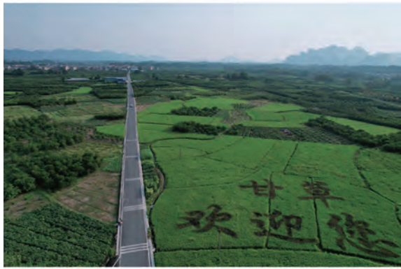
图 14 灵川县潭下至九屋公路
