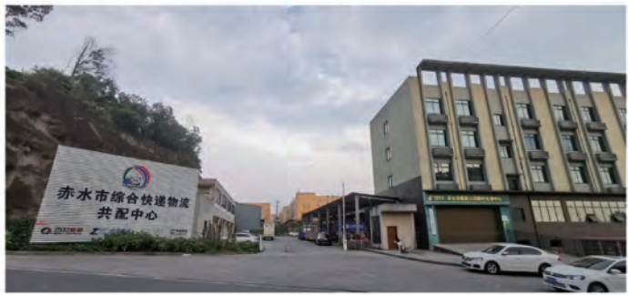
图6 综合快递物流共配中心
