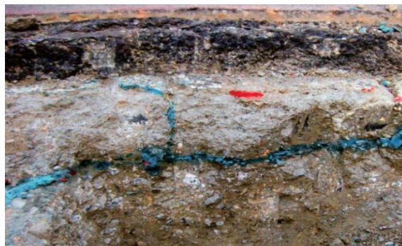
图 3 均质化处治（左：智能注浆；右：注浆后效果）
