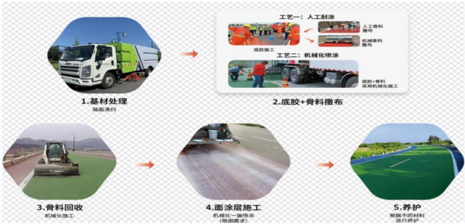
图 3 施工主要流程图
