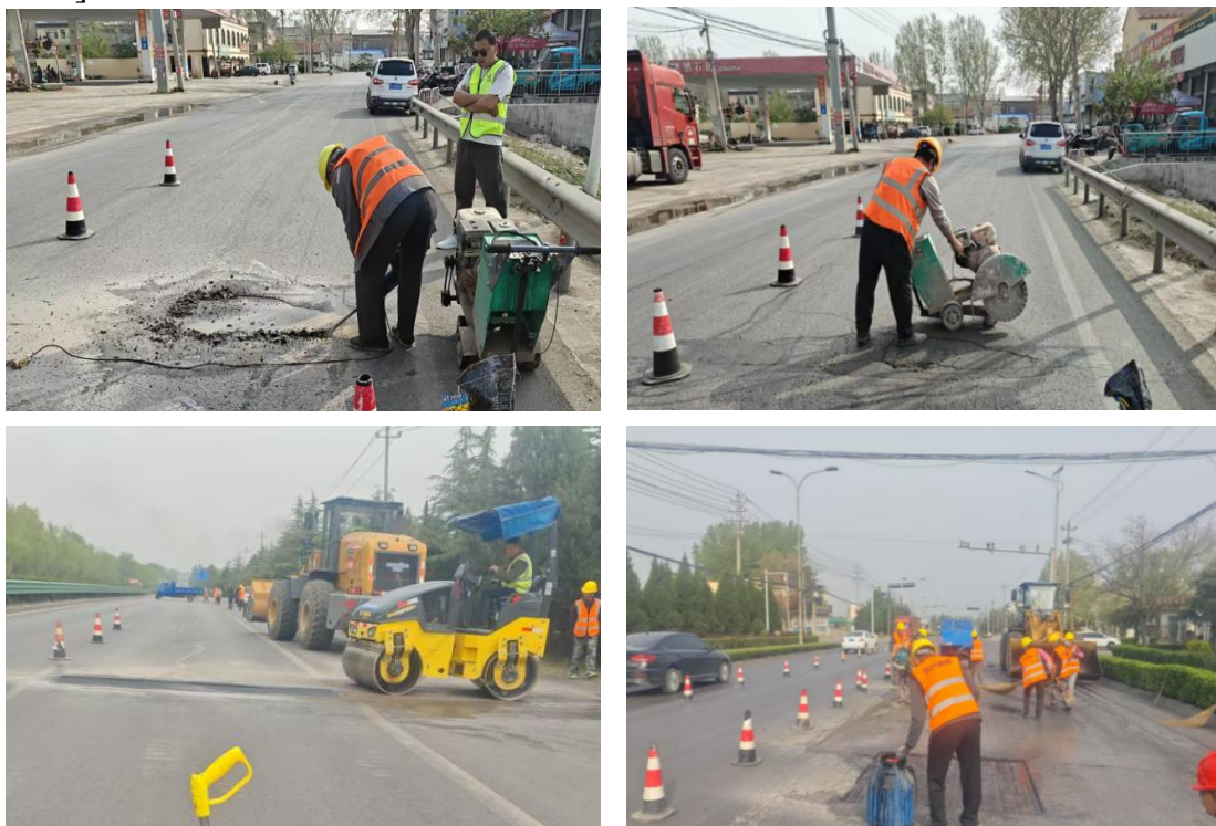
图 2 沥青路面坑槽修补施工流程图
