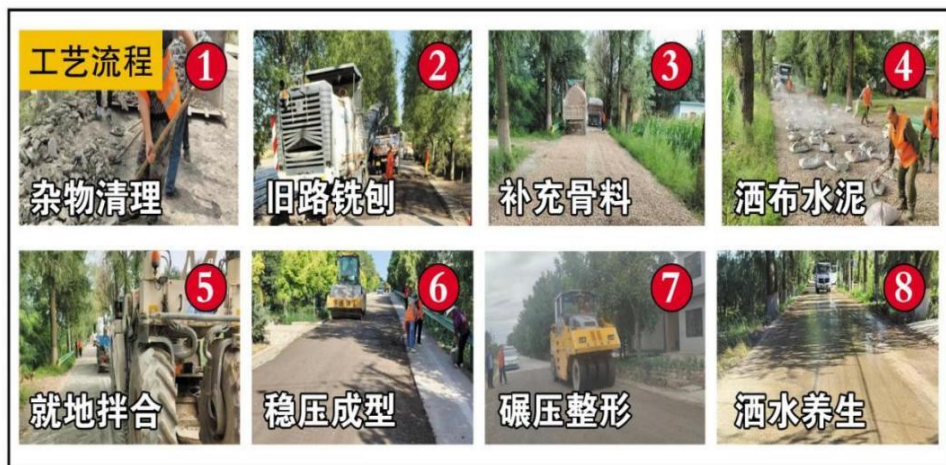
图 1 施工工艺流程
