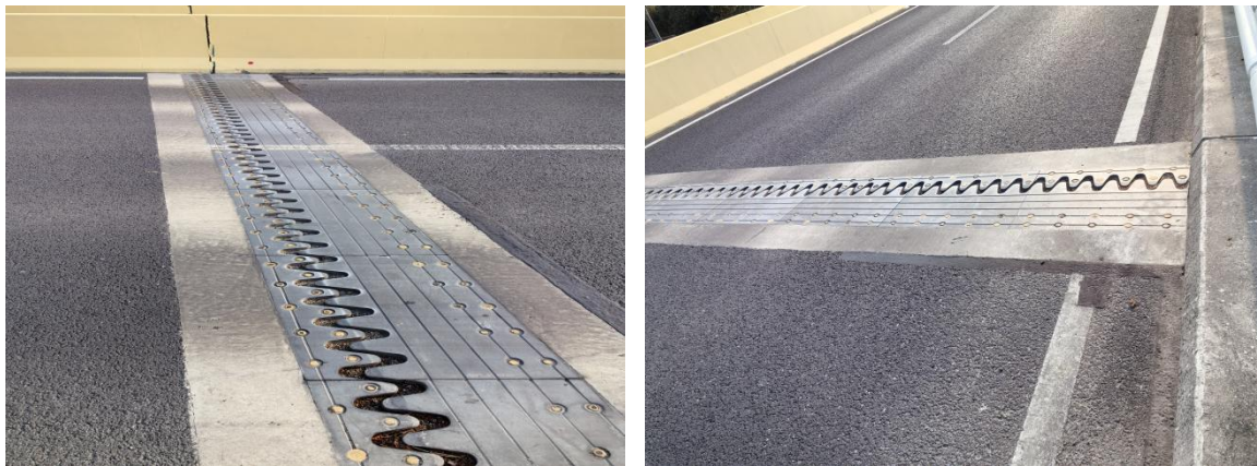
图 2 崇明大道桥梁伸缩缝积水病害维修后效果
