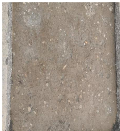
②清扫坑槽
