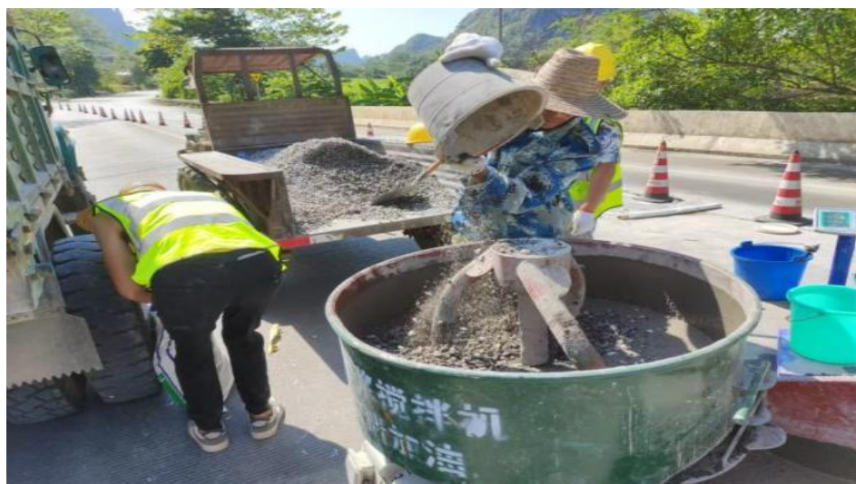
图 4 现场混合料拌和
