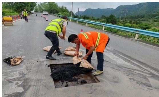
图 6 摊铺冷补沥青混合料
