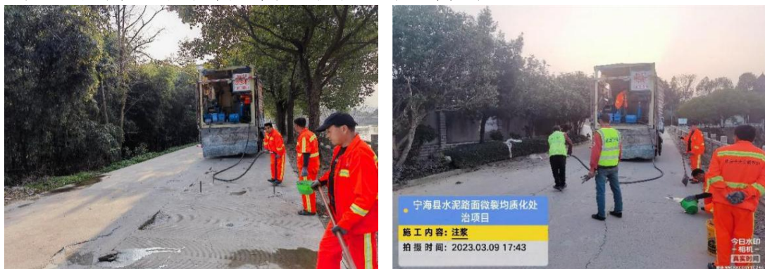
图 6 地聚合物注浆施工现场
