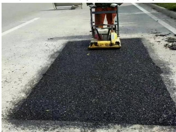
图 3 填料摊铺后整平初压
