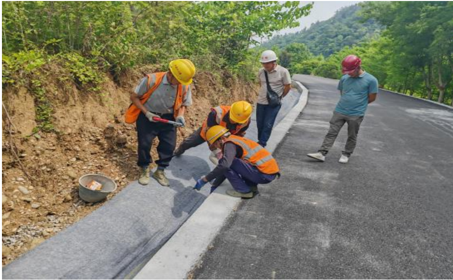
图 2 已完工的截水沟水泥毯
