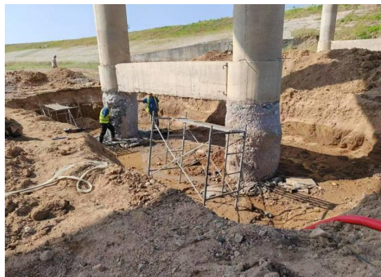
图 4 清除表面松散混凝土
