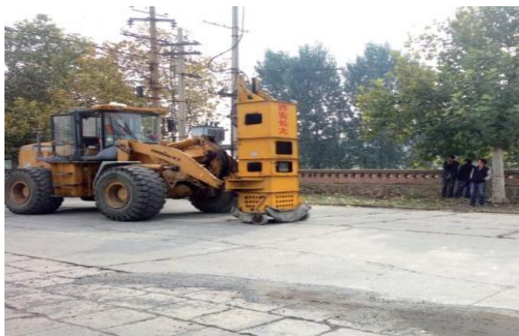
图 4 微裂再生施工（左：施工过程；右：施工后效果）
