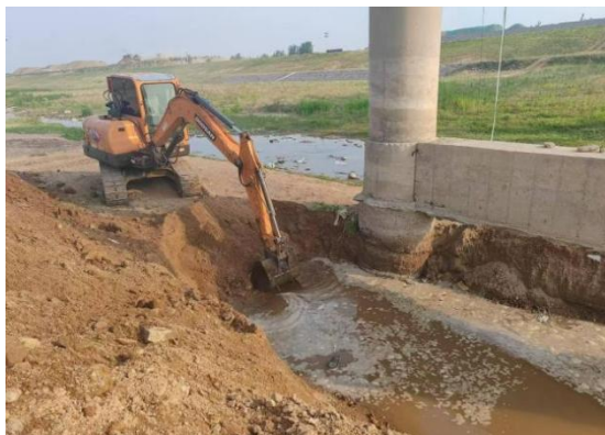
图 3 桩基开挖
