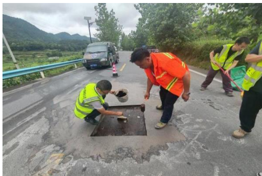
图 5 乳化沥青涂抹坑槽边缘
