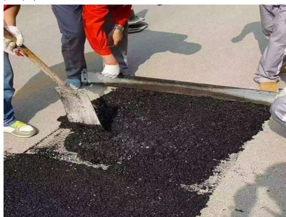
图 4 人工初压后平板机主压
