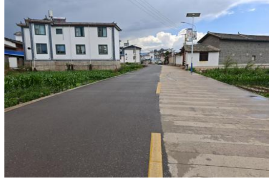
图 1 “白改黑”修复路段 2 年后实施前（左）实施后（右）对比
