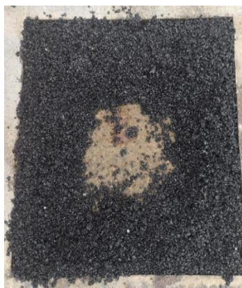
④冷补料摊铺
