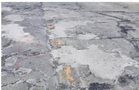
图 5 路面缺陷修复效果
