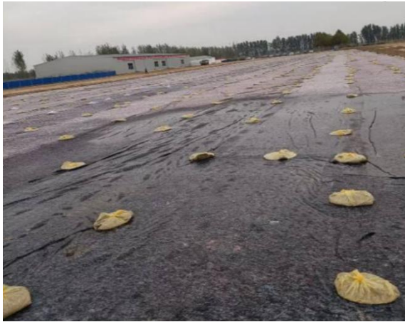
图 6 固化土二次整平、碾压
