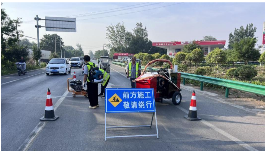
图 1 安全警示设置
