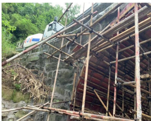
a)基础处理及支架搭设
