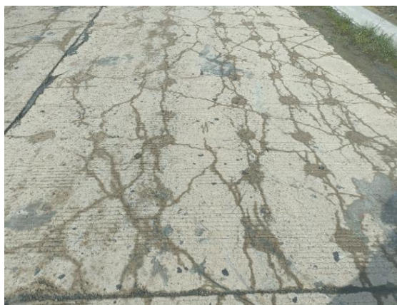
图 14 微裂再生后效果
