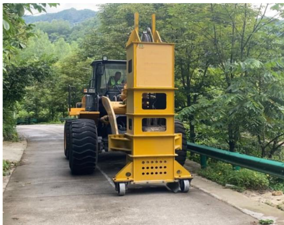
图 12 微裂施工现场
