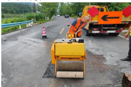
图 7 逐步压实冷补料
