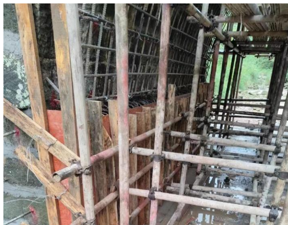
b)拱圈浇筑及拱上建筑加固
