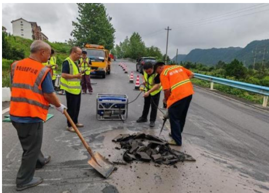
图 3 凿除坑槽及周边松散沥青
