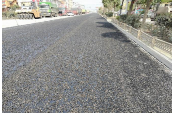
图 6 层间处理（左：铣刨、拉毛；右：橡胶沥青碎石封层工后效果）
