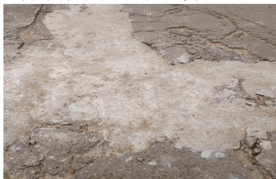
图 5 路面缺陷修复效果
