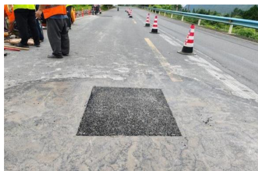
图 8 冷补料与原路面平顺衔接
