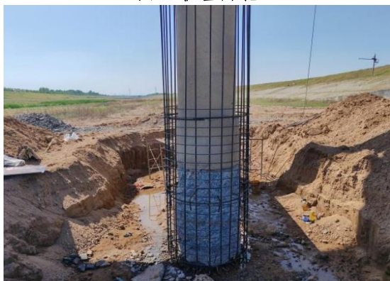
图 5 桩基植筋
