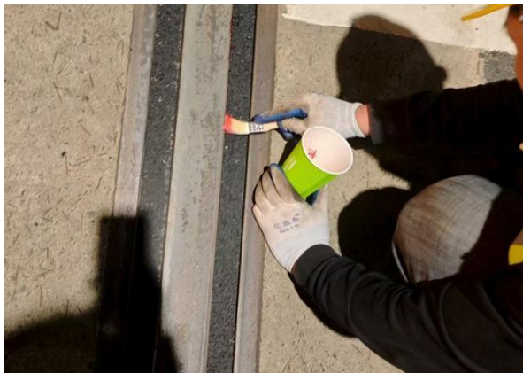
图 8 涂刷粘合剂、铺橡胶颗粒
