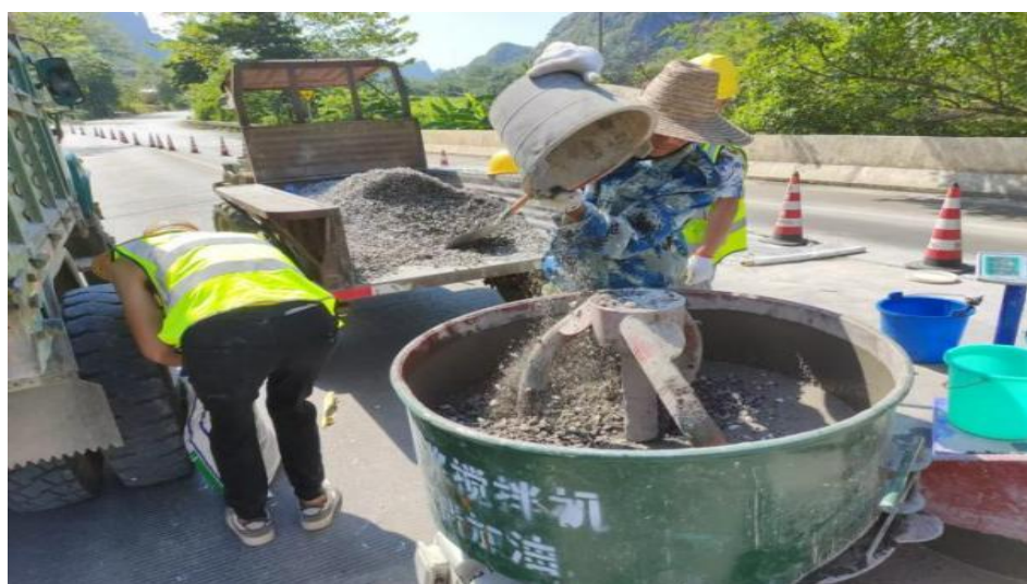
图 4 现场混合料拌和
