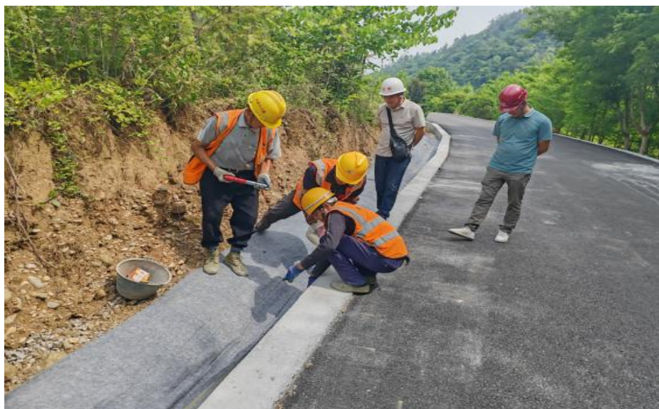
图 2 已完工的截水沟水泥毯
