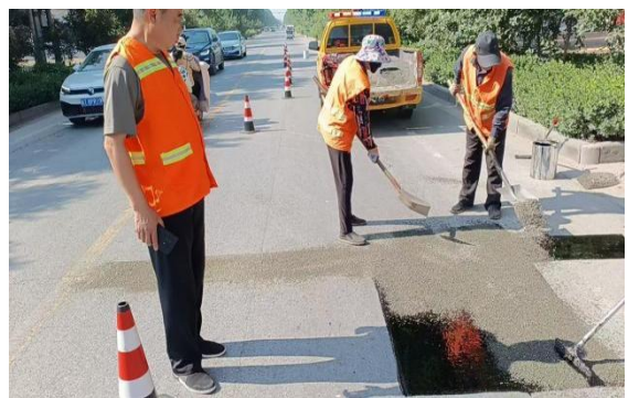
图 4 油层表面铺撒细粒玄武岩
