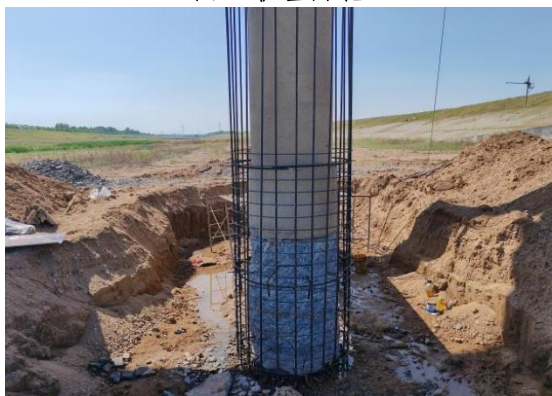
图 5 桩基植筋
