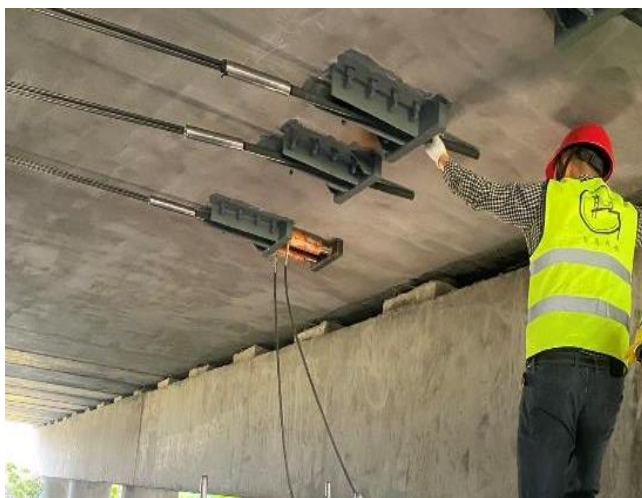
图 4 安装碳纤维索
