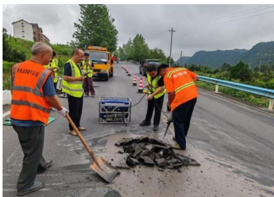
图 3 凿除坑槽及周边松散沥青
