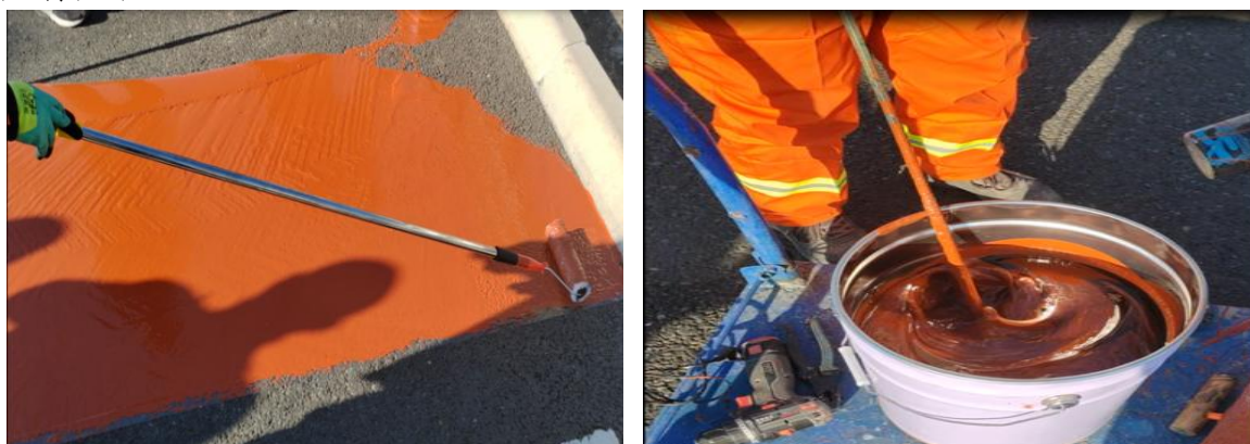
图 1 底胶调制施工现场
