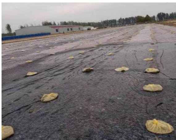
图 6 固化土二次整平、碾压
