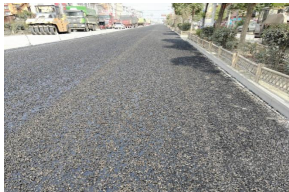
图 6 层间处理（左：铣刨、拉毛；右：橡胶沥青碎石封层工后效果）
