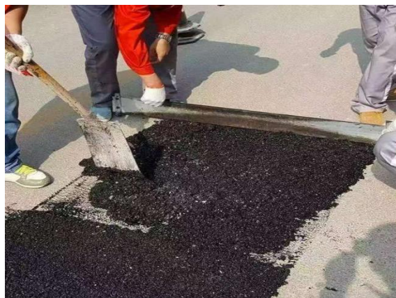
图 4 人工初压后平板机主压
