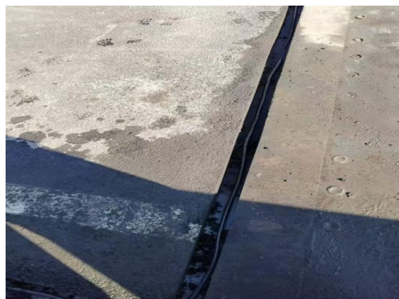
图 5 弹性混凝土沟槽恢复
