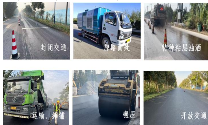
图3 高韧超薄沥青磨耗层流程示意图
