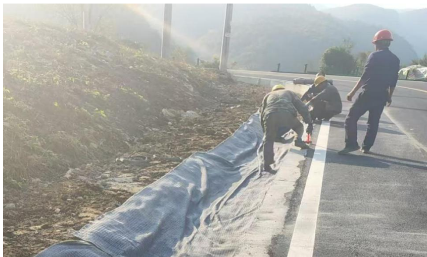
图 1 工人正在用锤子将锚固钉打入沟底及两侧边缘进行初步固定
