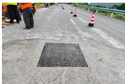
图 8 冷补料与原路面平顺衔接
