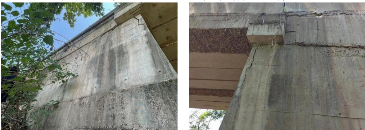
图 3 施工前桥台病害照片
