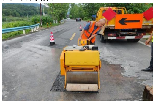
图 7 逐步压实冷补料
