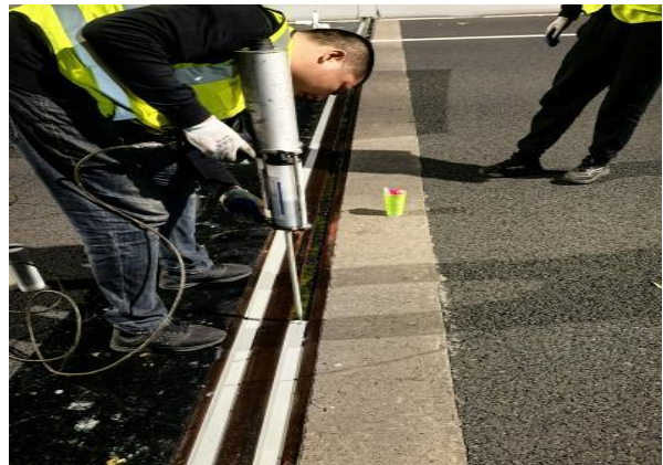
图 9 浇筑填缝料
