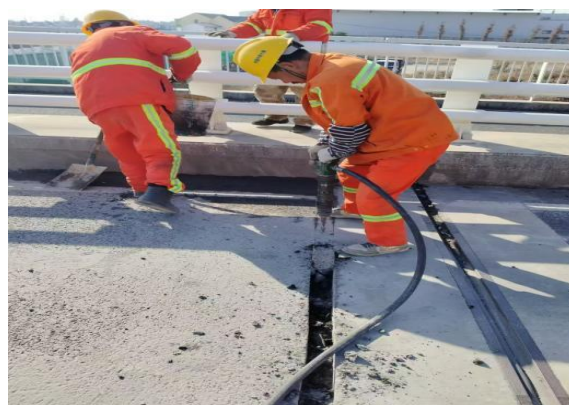
图 3 钻孔排水
