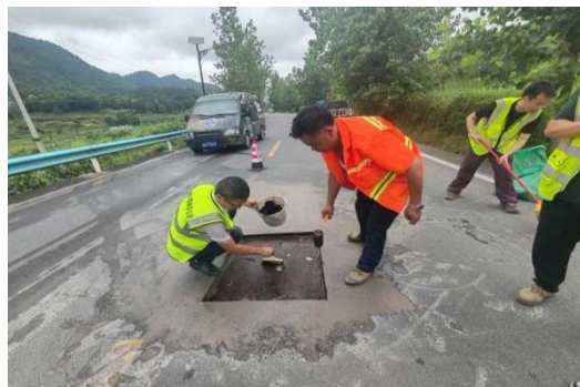
图 5 乳化沥青涂抹坑槽边缘
