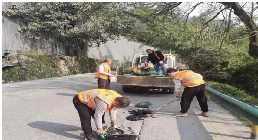
图 2 填料摊铺施工现场
