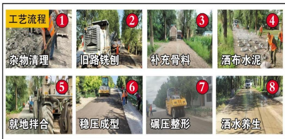
图 1 施工工艺流程
