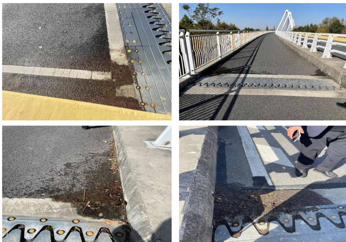
图 1 崇明大道桥梁伸缩缝积水情况
