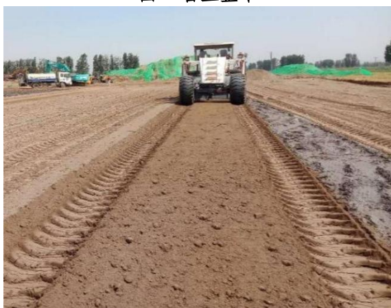
图 4 洒水车中稀释土壤固化剂
