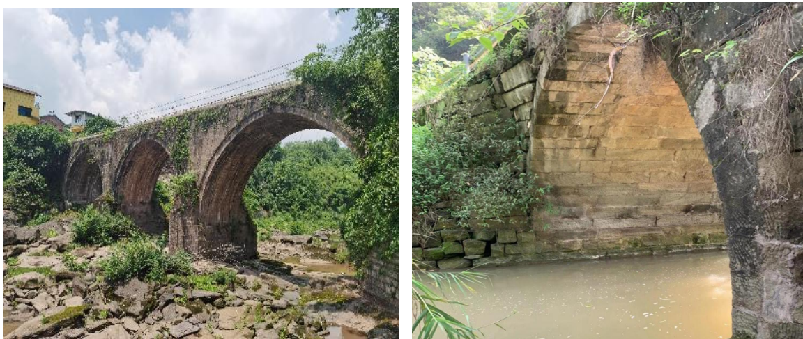
图 1 山区典型多跨实腹式石砌拱桥示意图
