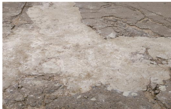
图5 路面缺陷修复效果
