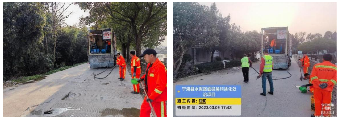
图 6 地聚合物注浆施工现场
