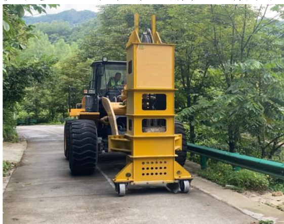
图 12 微裂施工现场
