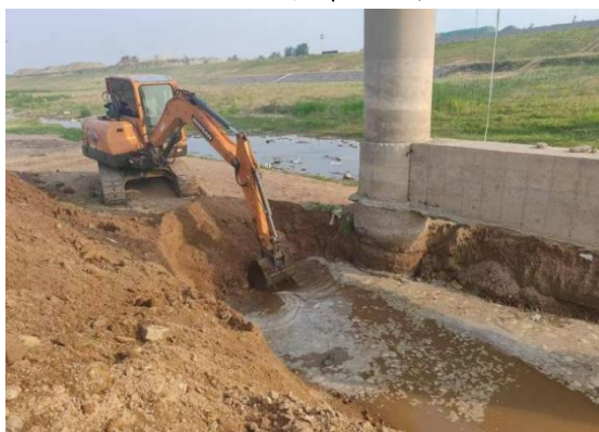
图 3 桩基开挖
