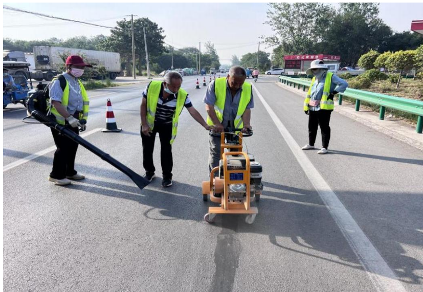
图 3 裂缝清理
