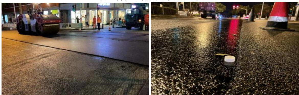
图 2 高韧超薄沥青磨耗层实操效果图
