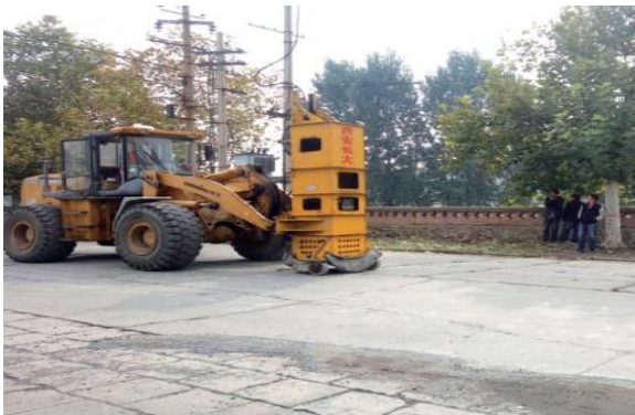
图4 微裂再生施工（左：施工过程；右：施工后效果）
