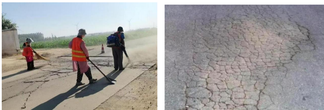
图 2 网裂路面清理
