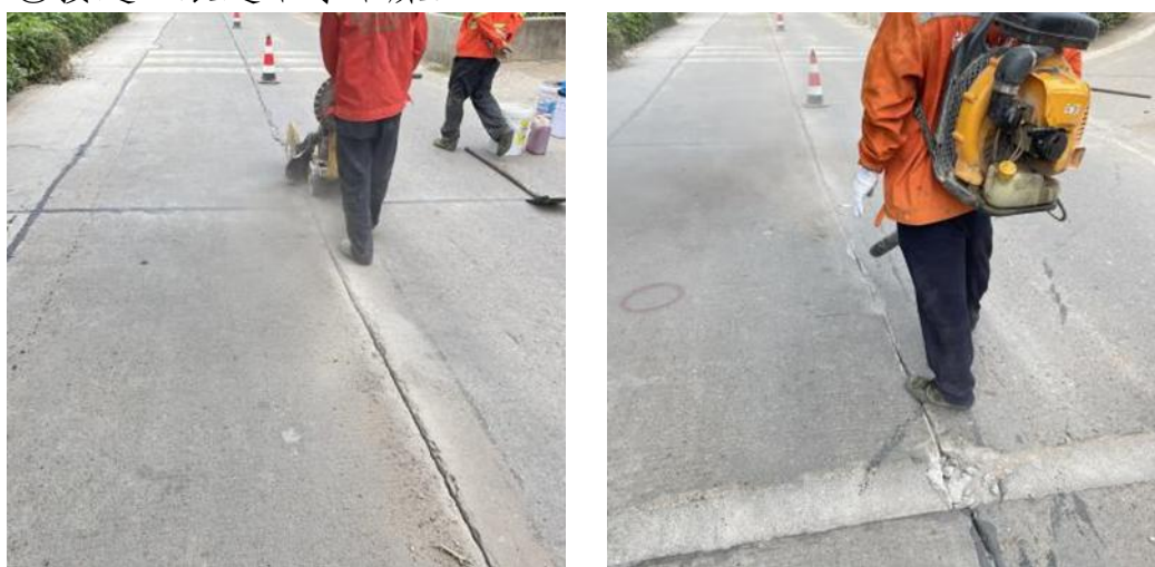
图 1 接缝清理
