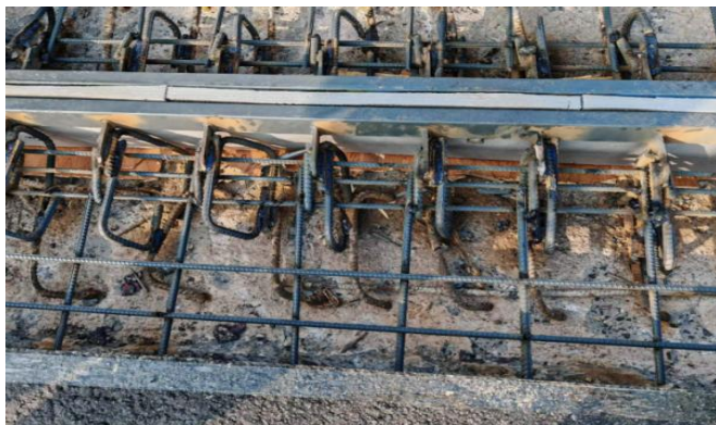
图2 焊接钢筋
