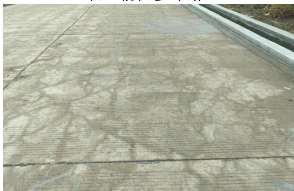
图 10 微裂再生后效果
