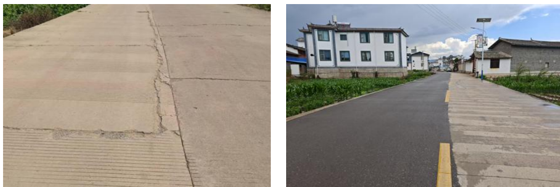
图 1 “白改黑”修复路段 2 年后实施前（左）实施后（右）对比
