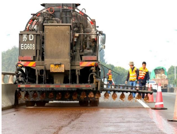
图 1 喷洒渗固剂
