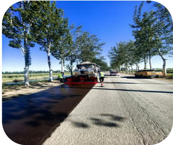
图 2 东光县南吴路微表处施工
