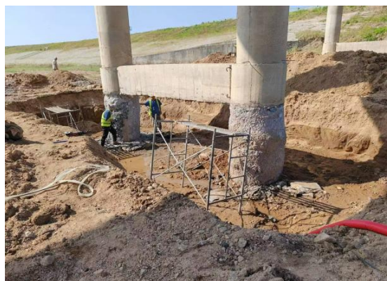
图 4 清除表面松散混凝土
