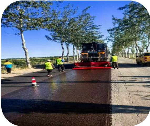
图 1 东光县辛霞路微表处施工
