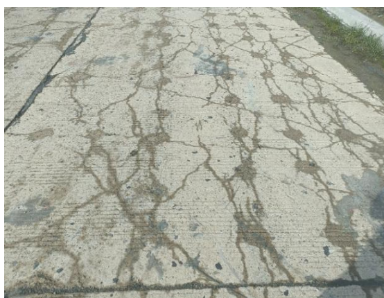
图 14 微裂再生后效果
