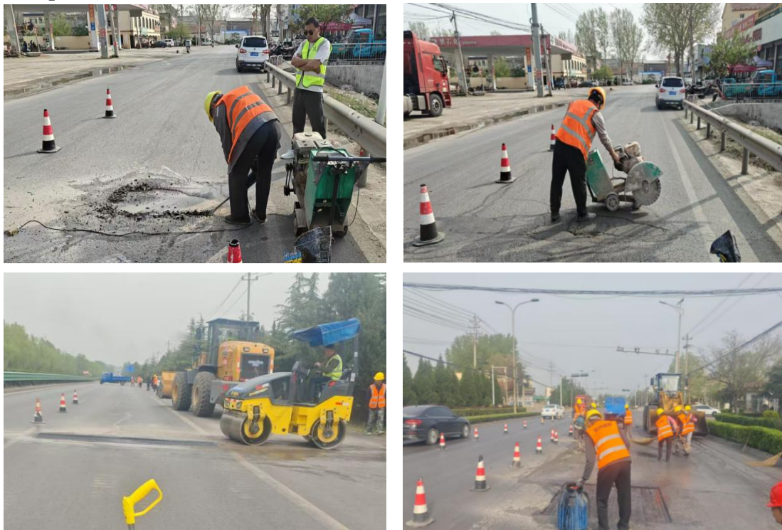
图 2 沥青路面坑槽修补施工流程图
