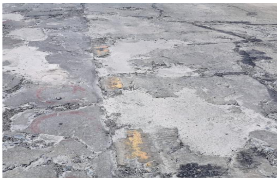
图5 路面缺陷修复效果
