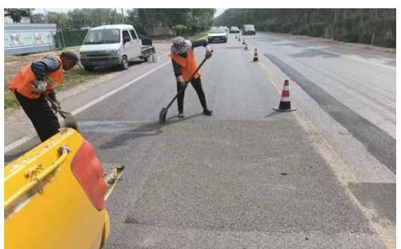
图 4 油层表面铺撒细粒玄武岩
