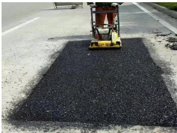
图 3 填料摊铺后整平初压
