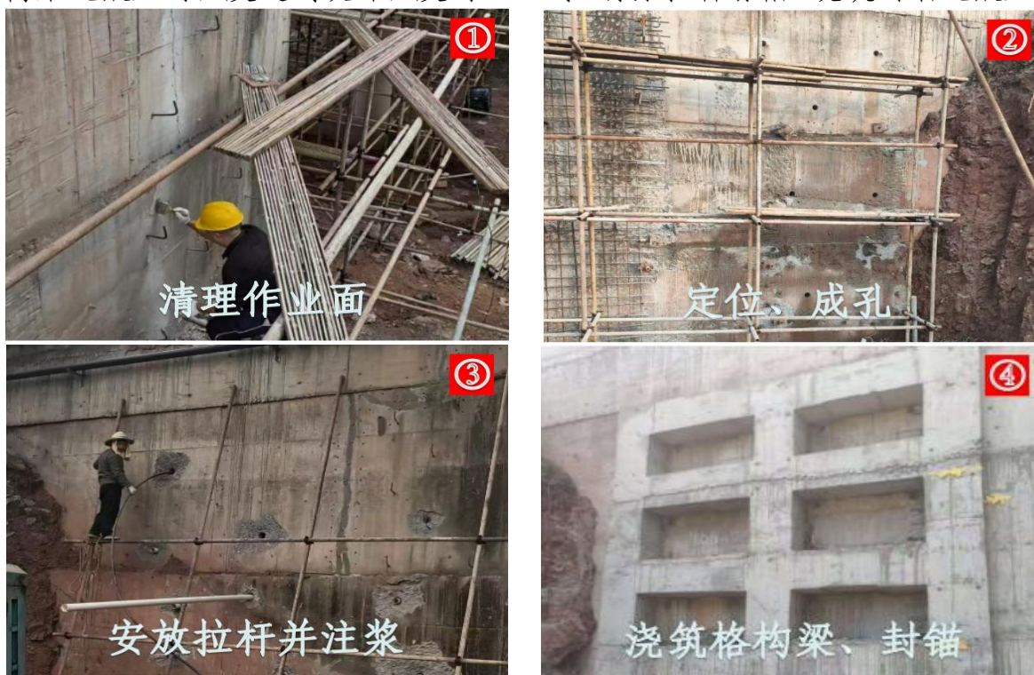
图 1 施工流程图
