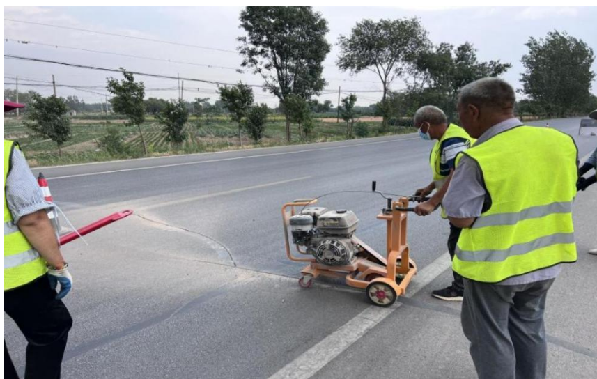
图 2 裂缝开槽
